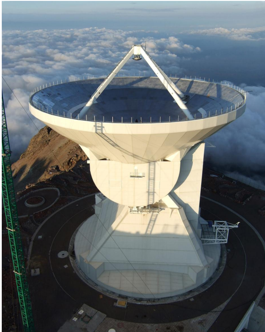
Figura 1 El Gran Telescopio Milimétrico ubicado al Volcán Sierra Negra, Puebla a 4600 metros de altura. Los 32-m de diámetro de una antena de 50-m están dentro de un tetrápodo de 4 patas. Las primeras observaciones científicas se seguirán realizando con un diámetro de 32-m.
